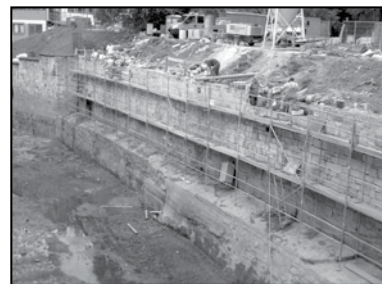
Wiederaufbau der Staumauer am ehemaligen Wassergraben
