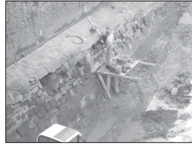
Instandsetzung des Fundaments am Großen Finkenherd
