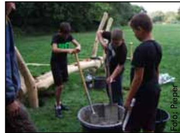
Mit Beton werden hier die Fundamente gesetzt.
